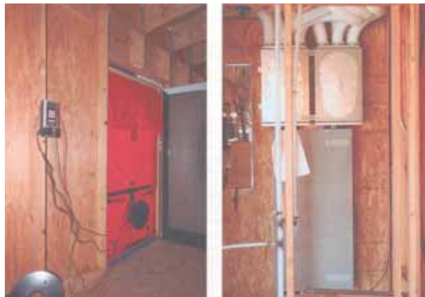
En la imagen de la izquierda, prueba/ensayo de BlowerDoor sobre un sistema AF sin el aislamiento. A la derecha, sistema de ventilación forma sintética.
